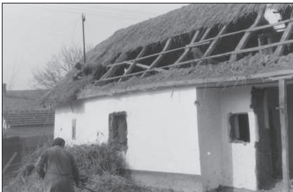
Construirea acoperișului de trestie
